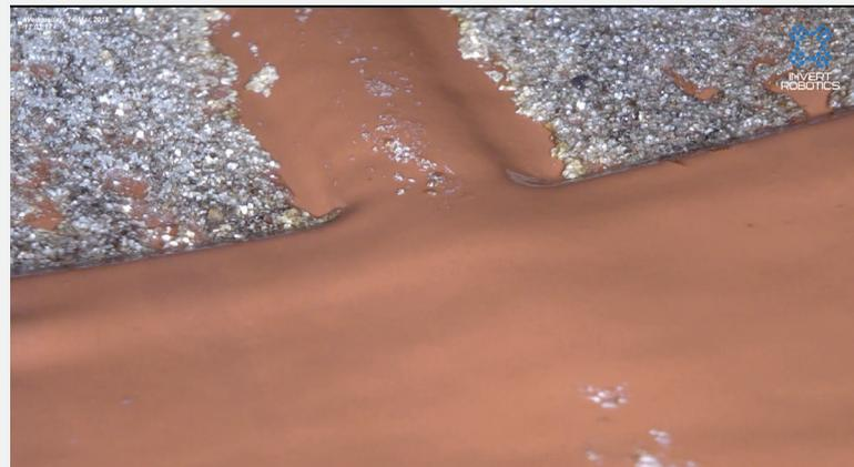
Die Oberfläche des Behälters sollte glatt und frei von Rückständen sein. Durch diese Delle können sich Rückstände festsetzen.
